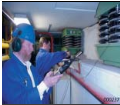
Fig. 3 Uso dell'analisi FFT per l'individuazione di difetti nell'isolamento da vibrazioni in una centrale elettrica
